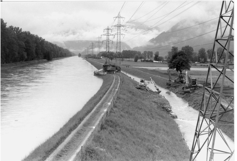
Notmassnahmen an der Linth in Benken Mai 1999
